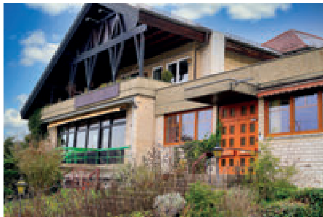
Außenansicht Landhotel „Lindenhof“
